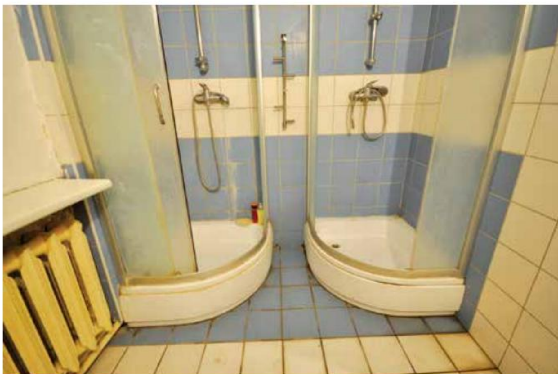
Tak wyglądała łazienka przed remontem...
